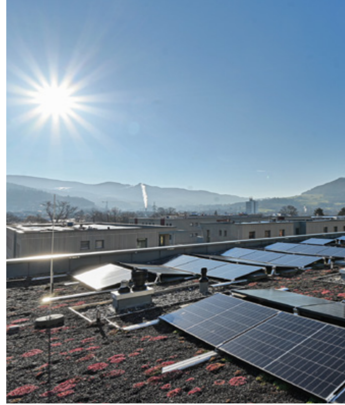
Auf den Dächern sorgen Photovoltaikanlagen für klimafreundliche Stromerzeugung aus Sonnenlicht.
