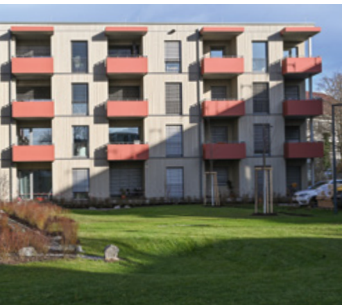
Mulden in den Grünflächen dienen der Regenwasserversickerung.
