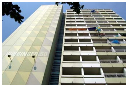
Sanierungsgebäude Bugginger Straße 50 im Quartier Weingarten. copyright: Freiburger Stadtbau GmbH
