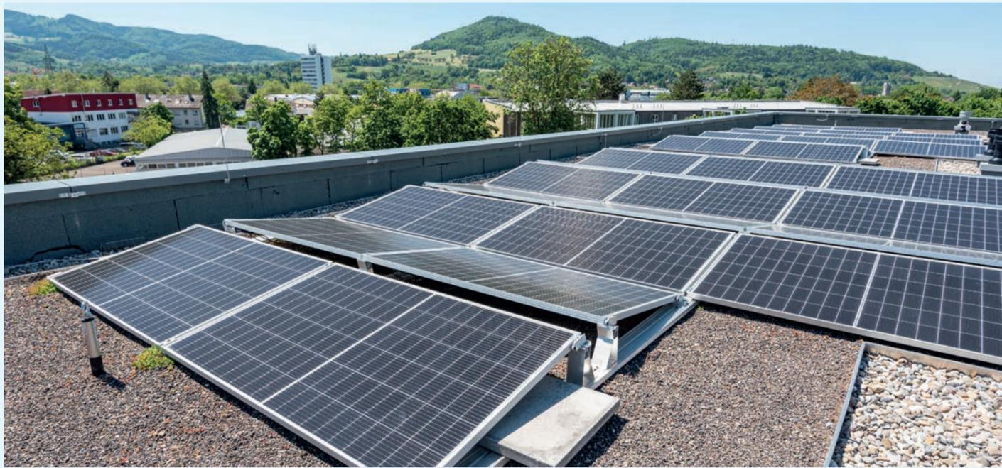
Photovoltaikanlage auf dem Dach eines Wohngebäudes im Schildacker
