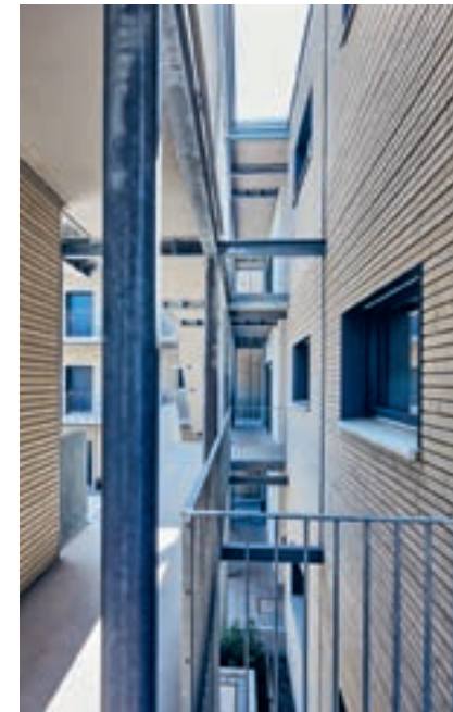
Ein wichtiger Meilenstein: vier dreigeschossige Holzhäuser in serieller Holzmodulbauweise mit Laubengängerschließung
