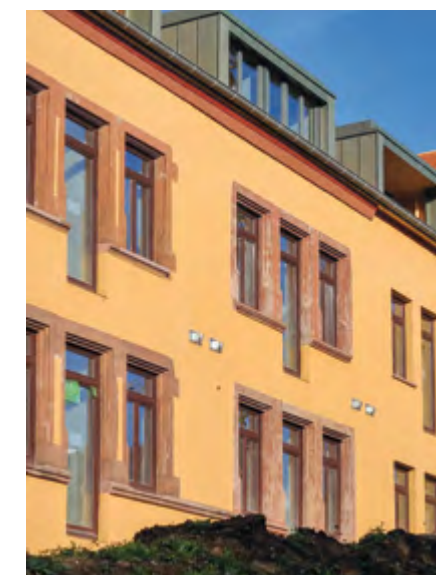
Der Breisacher Hof nach der Sanierung: Der historische Charakter bleibt erhalten.
