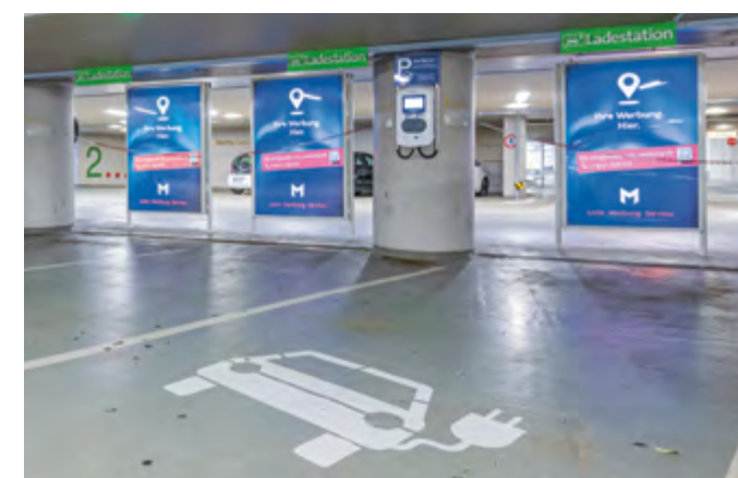
E-Ladestationen in den Parkgaragen des FSB Verbundes sorgen für bequemes Aufladen.
